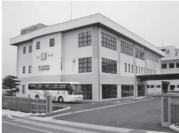
完成した人間ドックセンター(平成16年5月)
