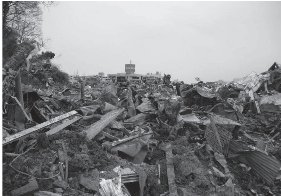
3月15日、陸前高田市に入った被災地支援班が撮影した市内中心地
