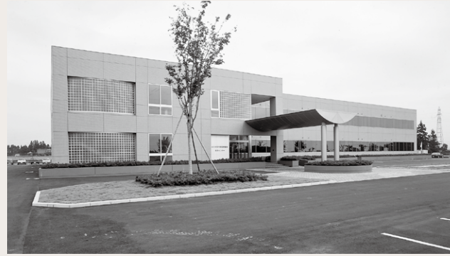
完成した県南センター
