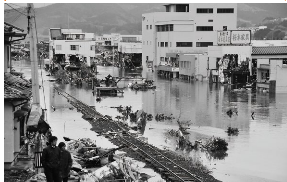
津波で建物や線路まで浸水し都市機能を失った大船渡市内 (左手前：偶然撮影された被災した健診班の2人)
