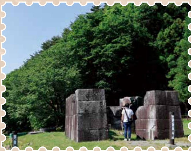
▲一番高炉 高炉とは、鉄鉱石を熱処理して鉄を取り出すための設備のことです。
