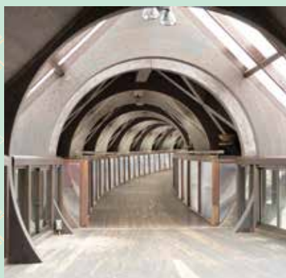
▲「きききのつりはし」は木造の大きな歩道橋です
