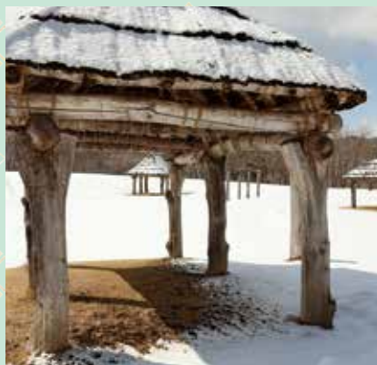
▲地面を掘り込んで柱を立てたという掘立柱建物（復元）
